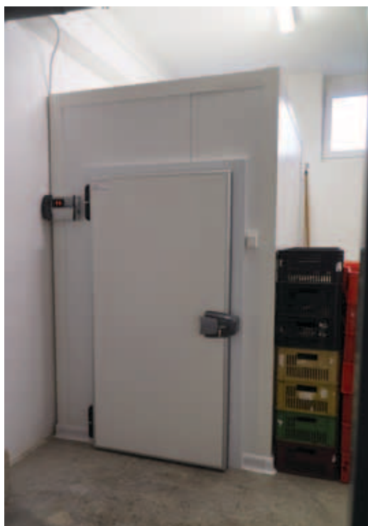
Výstavba chladicího boxu ve školní jídelně
