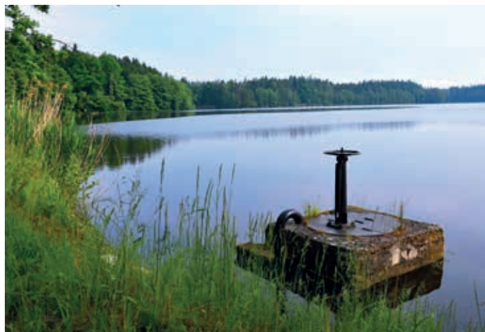
Výpustné zařízení rybníku Holub, červen 2021.
